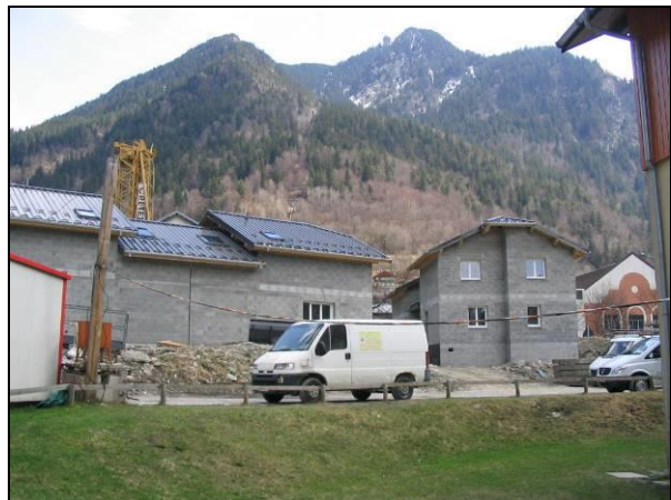
Photo 22 : Constructions de villas jumelées en cours
