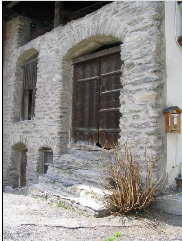
Photo 105 : Façades en pierres, ouvertures cintrées et escalier de pierres
