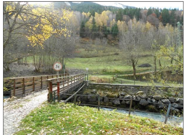
Photo 106 : Secteur ouest depuis le pont traversant le Doron à l'ouest de l'Ilaz
