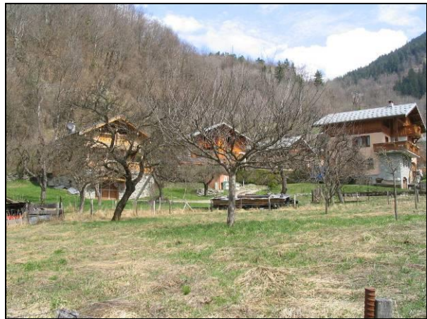
Photo 34 : Constructions récentes à l'arrière du vieux village
